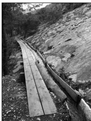
Die Arbeiten an der Suone Mengis wurden im April 2016 fertiggestellt. Eine Bauabnahme fand statt, die einzelnen Bauabschnitte wurden geprüft und in einem tadellosen Zustand vorgefunden. Das Wasser wurde ab der «Brinju» eingelassen und fliesst nun wieder seinen gewohnten Weg talwärts.
