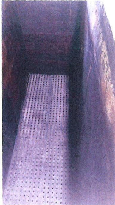
*Figure 6 : Vue à l'intérieur d'un bassin Biopur© C vide lors des travaux d'assainissement entrepris au printemps 2023.*
